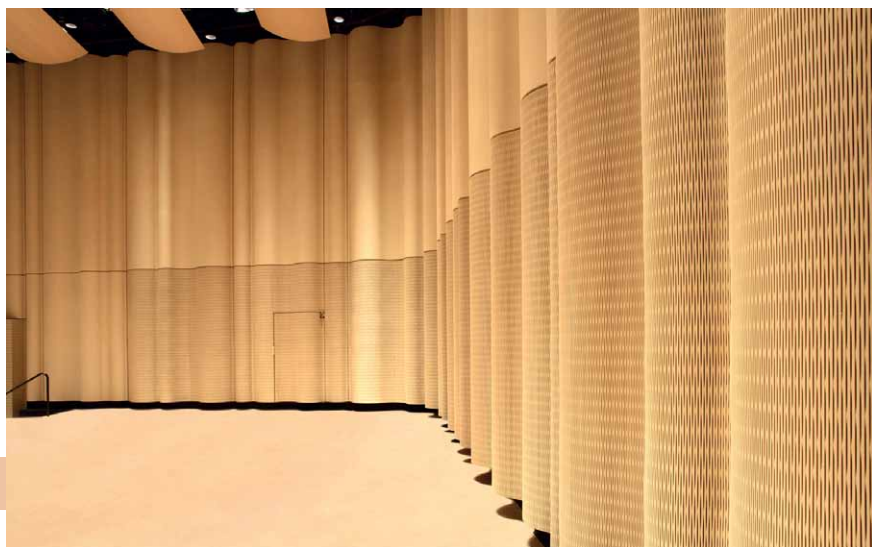
Dukta®-akustická stěna v koncertním sále, v provedení MDF
