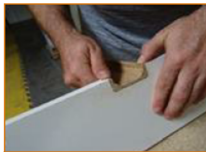
kontrola vyřezaného otvoru
